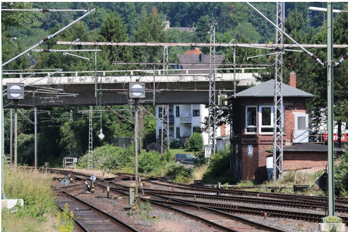
Am Bahnhof Lage kreuzen sich seit 1880 der Straßen- und der Schienenverkehr. Aber erst seit 1978 gehört der beschränkte Bahnübergang der Vergangenheit an. Die Brücke wird in diesem Jahr 45 Jahre alt. (Foto: Konrad Soppa)
