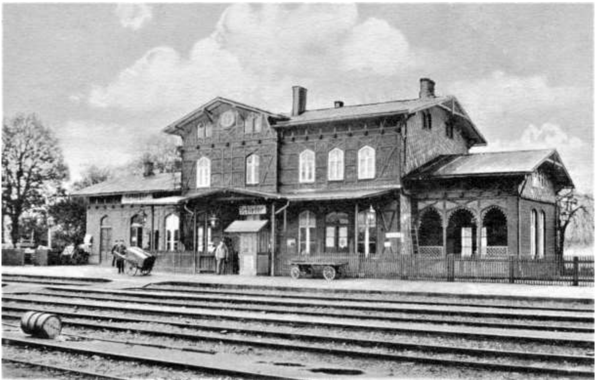
Das Empfangsgebäude auf Bahnhof Schieder, aufgenommen um ca. 1910. Es mußte schon längst einem schmucklosen Zweckbau weichen (Foto: Sammlung Konrad Soppa)
